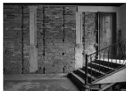
photo n°329 ...un espace délabré
